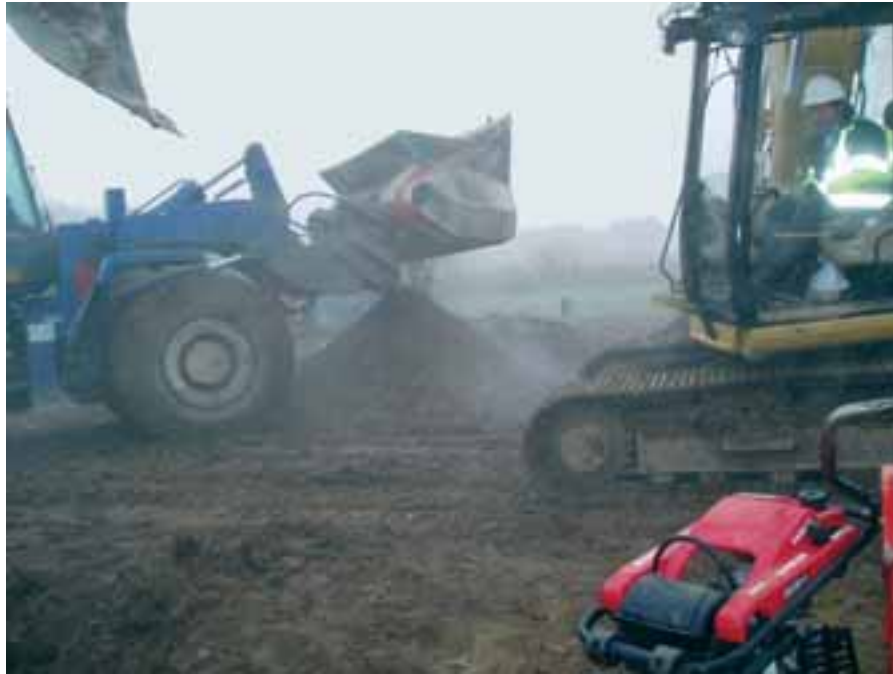
Mise en œuvre des traitements de sol in situ Application of soil treatments in situ
